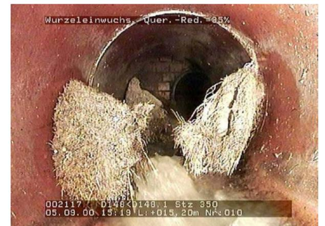
Abbildung 31: Ergebnisse einer Zustandsprüfung: Undichte Bestandsleitung mit eindringendem Grundwasser (oben); Wurzeleinwuchs (unten). (© GEB)
