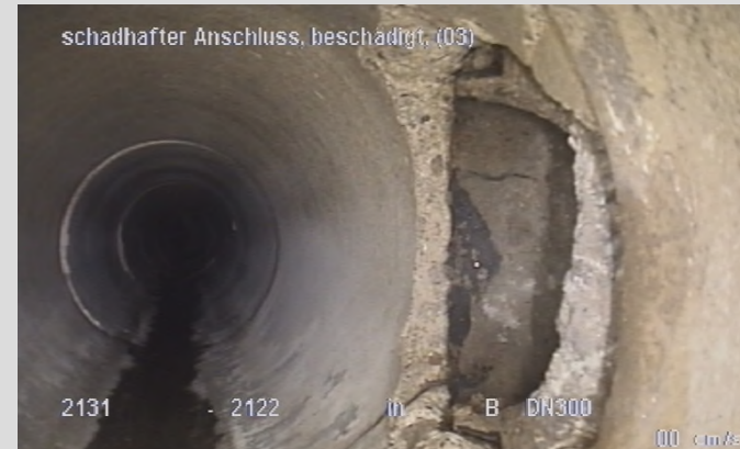
Schadhafter Anschluss
