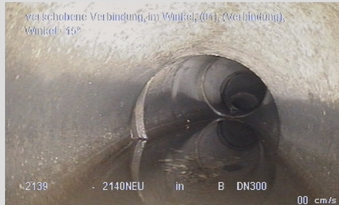
Verschobene Verbindungen
