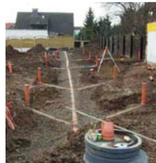
Die Mitarbeiter der Göttinger Entsorgungsbetriebe führen auch die Abnahme der neu verlegten Kanäle vor Ort durch. Hierbei werden alle Leitungen in offener Bauweise kontrolliert. Nach Verfüllung der Rohrgräben werden die Schmutzwasserkanäle und -schächte einer Dichtheitsprüfung unterzogen.
