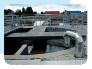
Kaskaden aufgeteilt; der nitrathaltige Rücklaufschlamm wird komplett direkt in die erste Kaskade geleitet. Jede Kaskade besteht aus einem Denitrifikationsbereich am Kaskadenanfang, in dem in einem sauerstoffarmen Milieu die Bakterien des Belebtschlammes den Sauerstoff des im Rücklaufschlamm ent-
